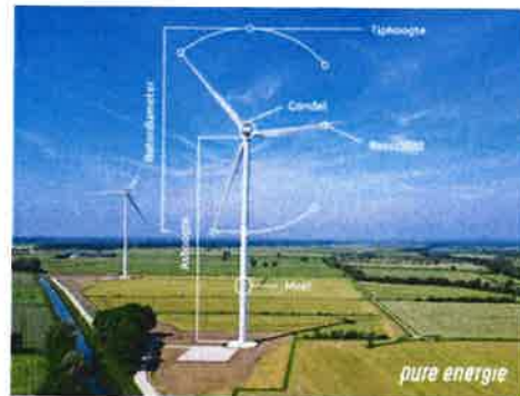
Namen van de onderdelen van een windmolen
